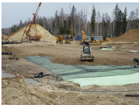
Рис. 7. Устройство гибкого ростверка
