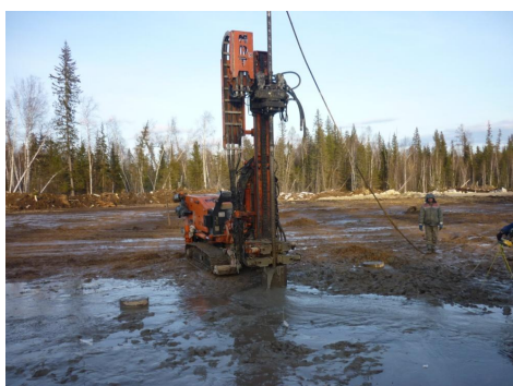
Рис. 5. Производство работ по технологии струйной цементации грунтов
